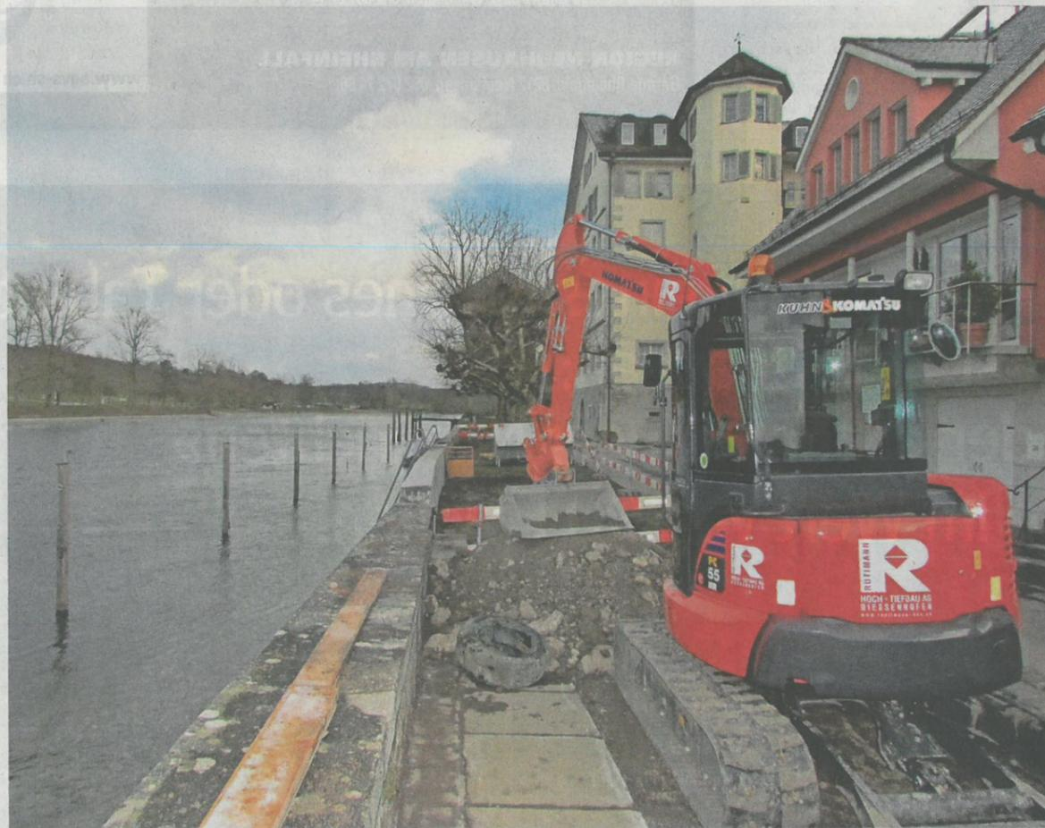
Eines der wichtigsten Arbeitsgeräte am Diessenhofer Rheinufer ist der Bagger. Er muss jedoch mit Bedacht eingesetzt werden, da sich das Mauerwerk abschnittsweise als akut einsturzgefährdet erwies.
